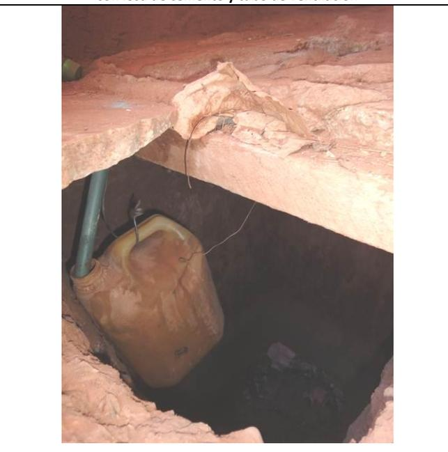
Comunidad "Pampa Colorada" Colquechaca-Potosí, letrina pozo ciego con separación de orina a través de conductos; reutilización de orina para fumigación
