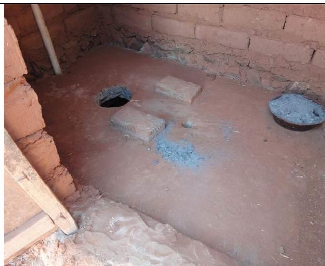
Comunidad "Pampa Colorada" Colquechaca-Potosí, letrina pozo ciego con losa de cemento y tubo de ventilación
